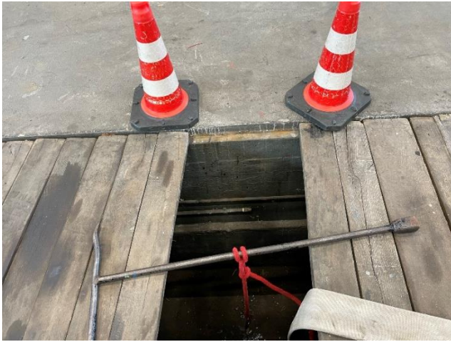
TP hochgehungen über einem Schacht mit Unterflurhydrantenschlüssel
